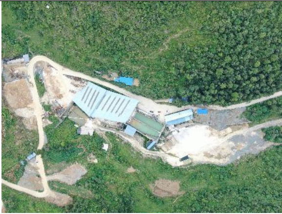
选厂厂区及周边环境俯瞰
