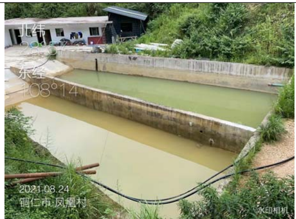
项目已建循环水池
